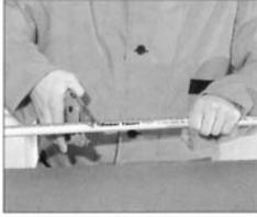
Se taie teava din PP-R pe directia perpendicular pe axa, cu ajutorul unei foarfece speciale. Sudura se realizeaza cu aparatul de polifuziune. Sudura trebuie sa se execute la 260°C. In functie de diametrul tevii care trebuie prelucrata, se alege si se monteaza matrita corespunzatoare pe aparatul de lipire. Matrita de sudura se curata inainte de utilizare
