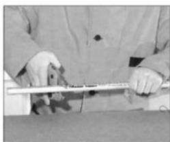
Se taie teava din PP-R pe directia perpendicular pe axa, cu ajutorul unei foarfece speciale. Sudura se realizeaza cu aparatul de polifuziune. Sudura trebuie sa se execute la 260°C. In functie de diametrul tevii care trebuie prelucrata, se alege si se monteaza matrita corespunzatoare pe aparatul de lipire. Matrita de sudura se curata inainte de utilizare.
