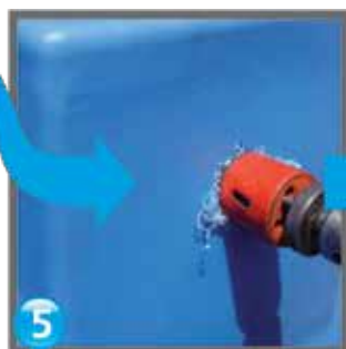
Se găurește cu freză pentru lemn sau plastic drilling/ просверливание
