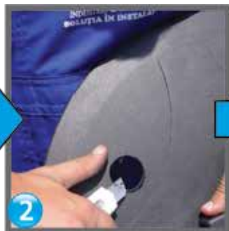
Se debavurează gaura finishing the hole/ обрезка
