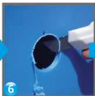
Se debavurează gaura finishing the hole/ обрезка
