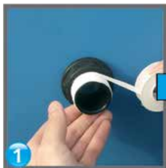
Etanșarea cu teflon sealing/ изоляция тefлоном
