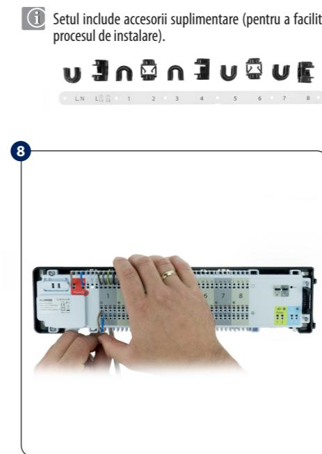
Ajustați firele și înșurubați carcasa albă la carcasa neagră a centruului de comandă.
